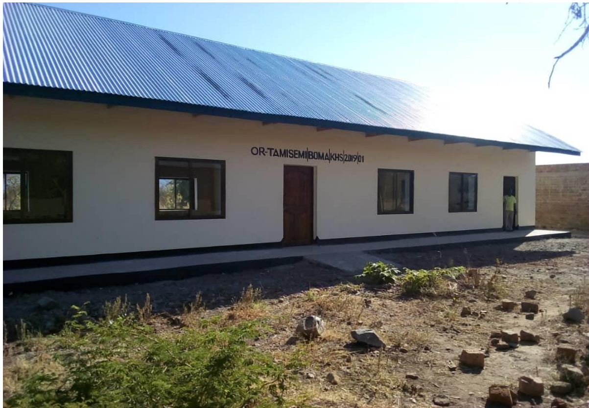
13. Vyumba vya madarasa katika shule ya Sekondari Kirando iiyopo Wilaya ya Nkasi Mkoa wa Rukwa
