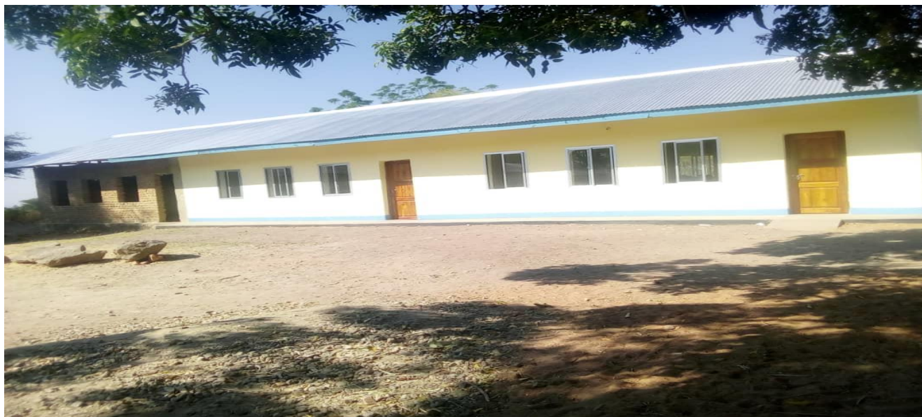
6. Vyumba vya madarasa Shule ya Msingi Chalantai iliyopo Wilaya ya Nkasi Mkoa wa Rukwa
